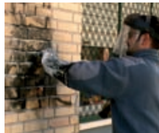
Eliminando pintadas de la fachada.
