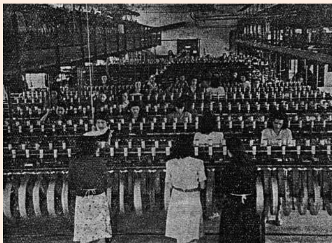
Vista parcial de una nave de la fábrica de Orihuela. Seda hilada y torcida.
